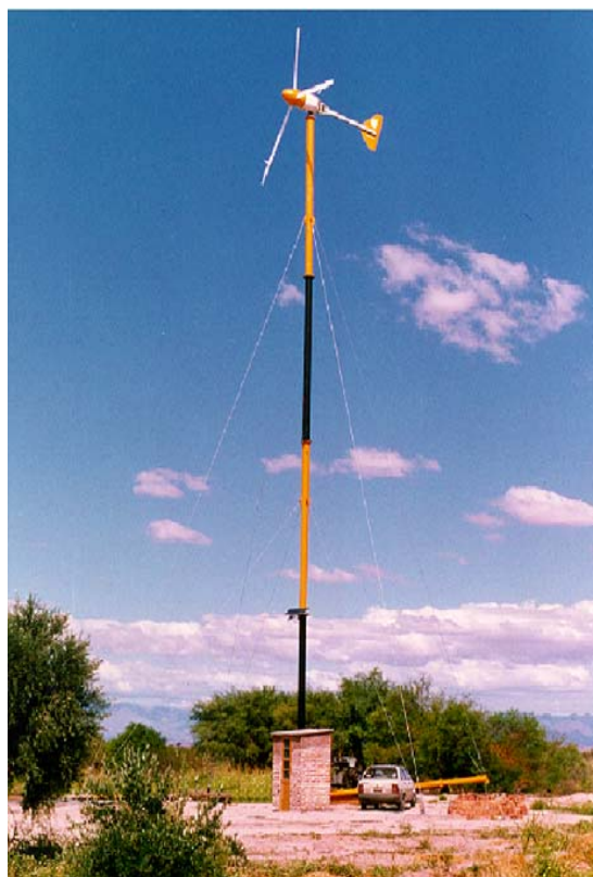
BERGEY 10 kW Diámetro Hélice 7 mts Instalado por Lic. D.A.Franco
