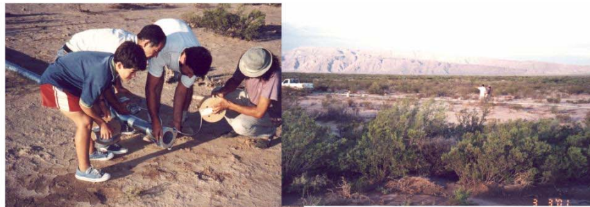
Construcción de bases y Armado de la Torre
