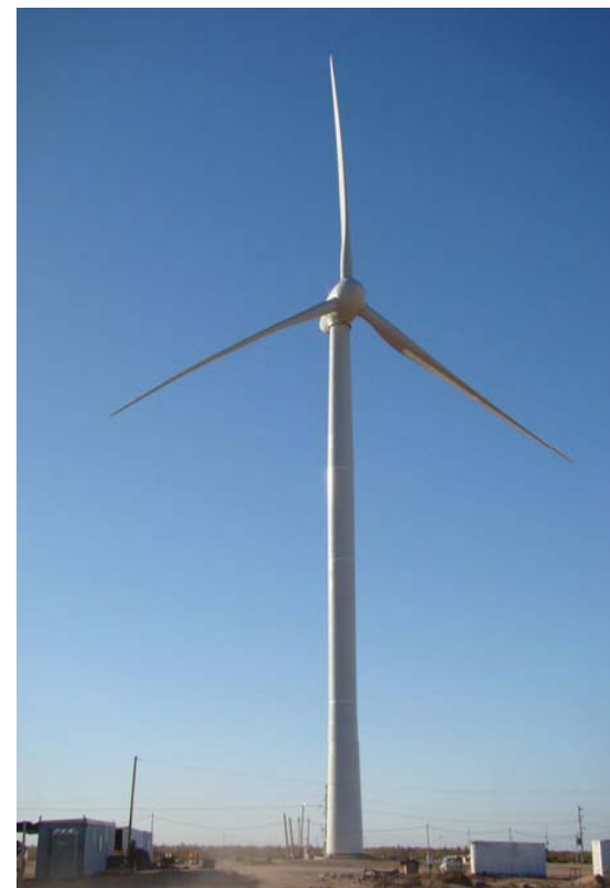
IMPSA WIND 2,1 MW Diámetro Hélice 83 mts Instalado por IMPSA WIND
